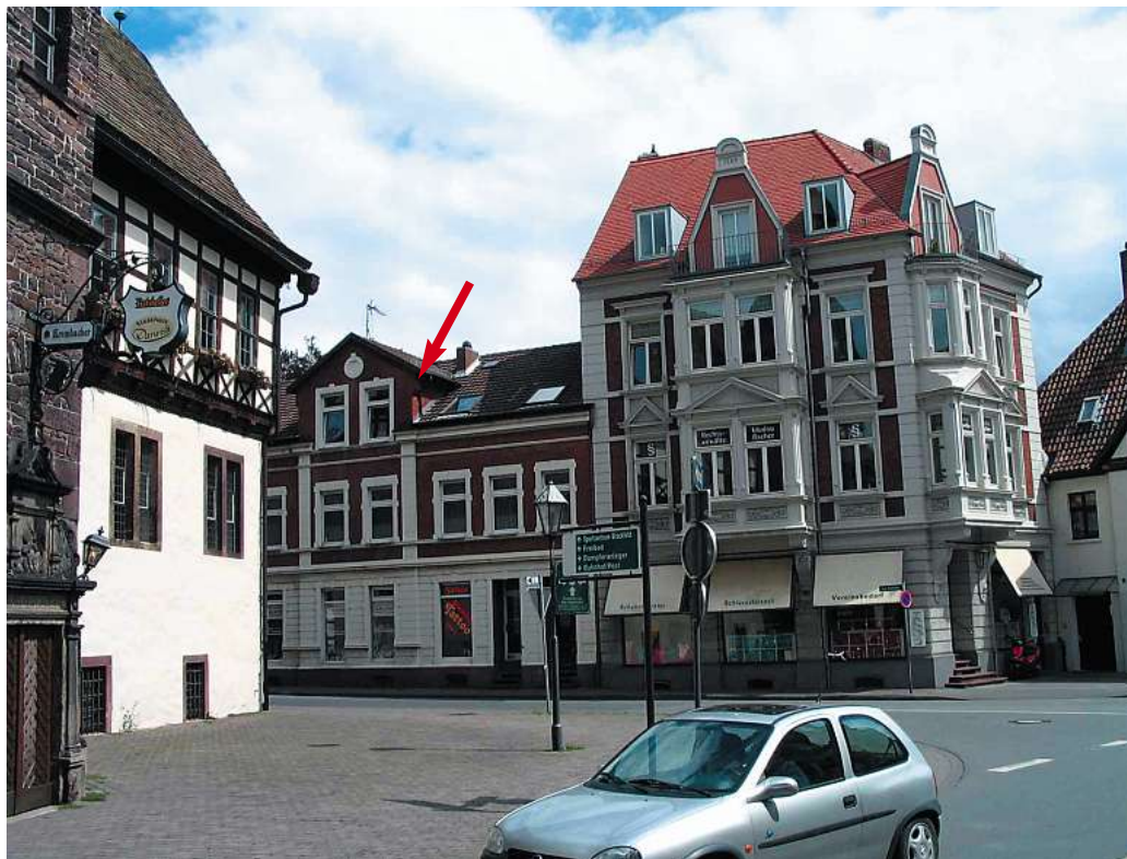
Das Gebäude »Am Rathaus 11« (siehe Pfeil) wurde durch die Explosion am 19. September 2005 völlig zerstört. Die umliegenden Gebäude, hierunter auch das »Historische Rathaus« (vorne links), trugen zum Teil erhebliche Schäden davon.
